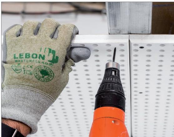
Fixieren Sie die Platten mit Schrauben für Lochdecken mit einem maximalen Abstand von 17cm.
