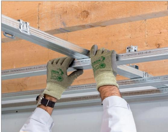
Fixieren Sie die Grundprofile CD60/27/06. Positionieren Sie die Kreuzverbinder entsprechend dem Fugenraster (max. Abstand 33,3cm) für die Tragprofile CD60/27/06. Die Kreuzverbinder müssen auf die Profile abgestimmt sein und dürfen kein Spiel haben.
