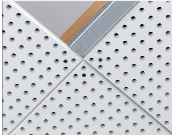
Positionieren Sie die Platten mithilfe der passenden Montagehilfe Kante an Kante. Überprüfen Sie die korrekte Ausrichtung der Lochung in Längs-, Quer- und Diagonalrichtung.
