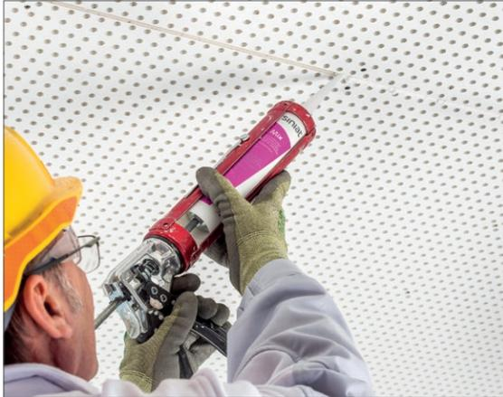
Tragen Sie mit einer manuellen (oder elektrischen) Kartuschenpistole den Siniat Mix-Fugenfüller oder Pallas Fill kontinuierlich auf.
