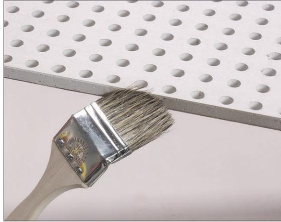
Auch wenn die Ränder der Createx Platten vorgrundiert sind, empfiehlt es sich, Siniat Haftprimer auf alle Ränder der Platten aufzubringen, damit der Staub von Transport und Lagerung gebunden wird. Gerade Ränder, die beim Schneiden vor Ort entstehen, müssen gereinigt und grundiert werden.
