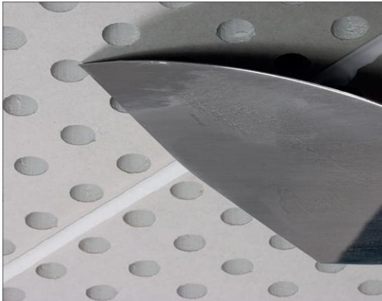
Nach 5 bis 10 Minuten kann der größte Teil des Überstandes mit einem leicht gebogenen Spachtel abgestoßen werden, so dass nur noch ein geringer Überstand zurückbleibt.
