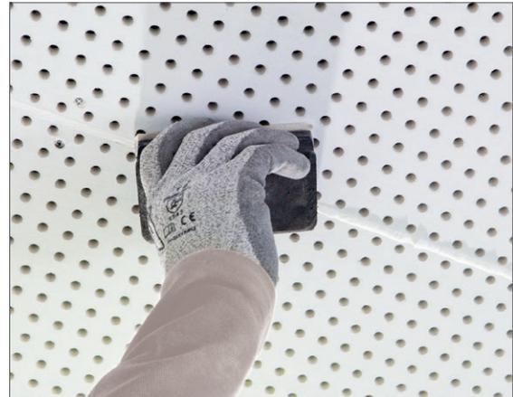
Nach vollständiger Trocknung des Fugenfüllers (ca. 12 bis 24 Stunden) die getrockneten und verspachtelten Flächen mit einem Hand- oder Stielschleifer eben schleifen. Werden Flächen maschinell abgeschliffen, muss unbedingt darauf geachtet werden, dass der Karton nicht beschädigt wird. Geschliffene Kartonstellen zeichnen sich sonst bei Anstrichen oder Beschichtungen ab. Außerdem können durch Vibrationen Risse entstehen.
