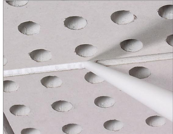
Die Fugen der Createx Helix- und LaCoustic-Platten sind satt mit Siniat Mix-Fugenfüller oder Pallas Fill auszufüllen, so dass sie vollständig gefüllt und die Kartonränder benetzt sind. Schraubenköpfe sind ebenfalls zu verspachteln. Für die Fuge und bei der Erstellung von Friesen kann Pallas Fill verwendet werden.
